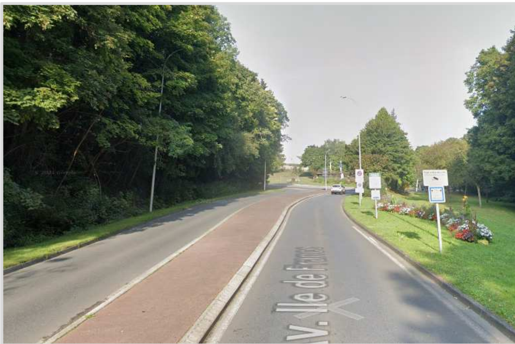
Photo 3 : vues des accès Nord et Sud par l'avenue de l'Île de France (source Streetview).
